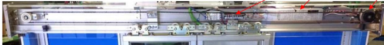
●重量級ドア質量対応ギアレスモータ&コントローラをフロント両端に取付け、2軸同時運転する場合の設置例
